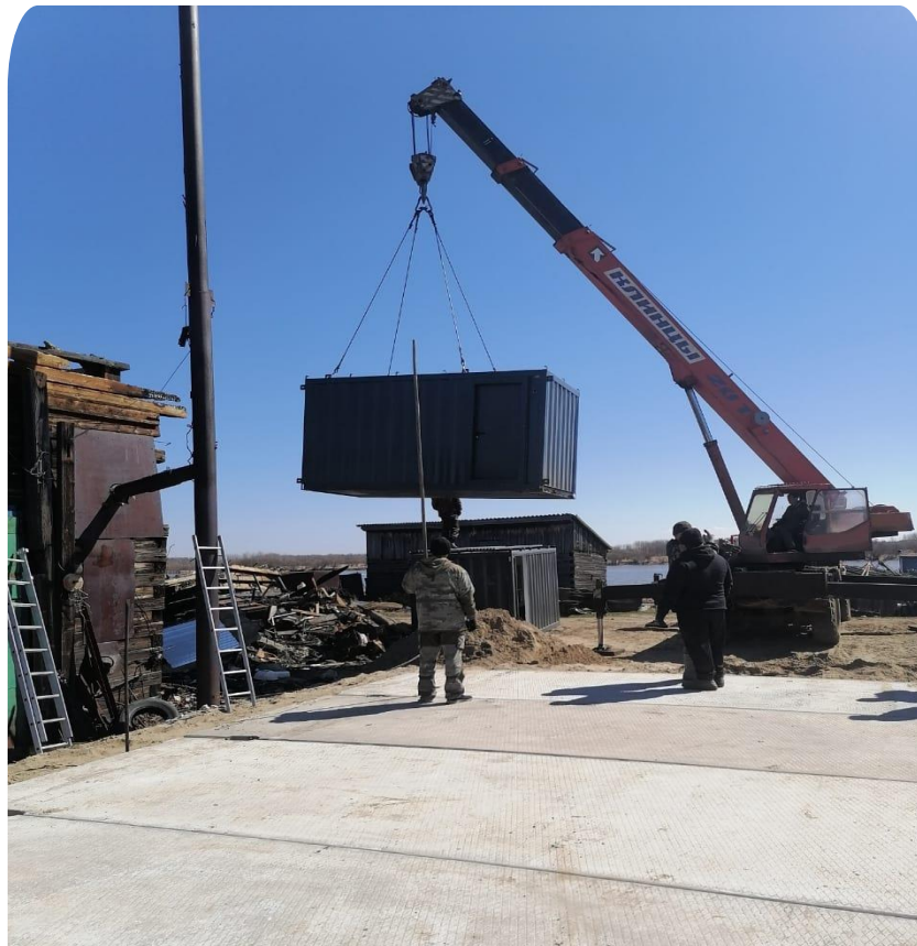
УСТАНОВКА НОВОЙ МОДУЛЬНОЙ ДИЗЕЛЬНОЙ ЭЛЕКТРОСТАНЦИИ
