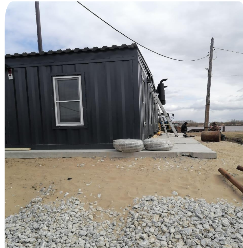
УСТАНОВКА НОВОЙ МОДУЛЬНОЙ ДИЗЕЛЬНОЙ ЭЛЕКТРОСТАНЦИИ
